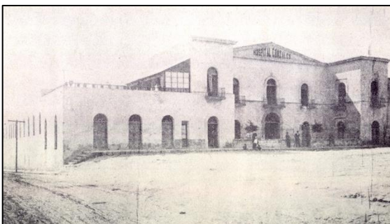
Primer Hospital Civil de Monterrey (1860)
